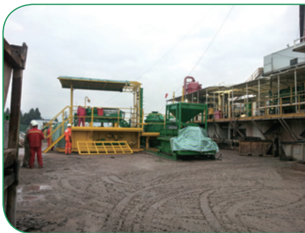
壳牌四川项目现场
