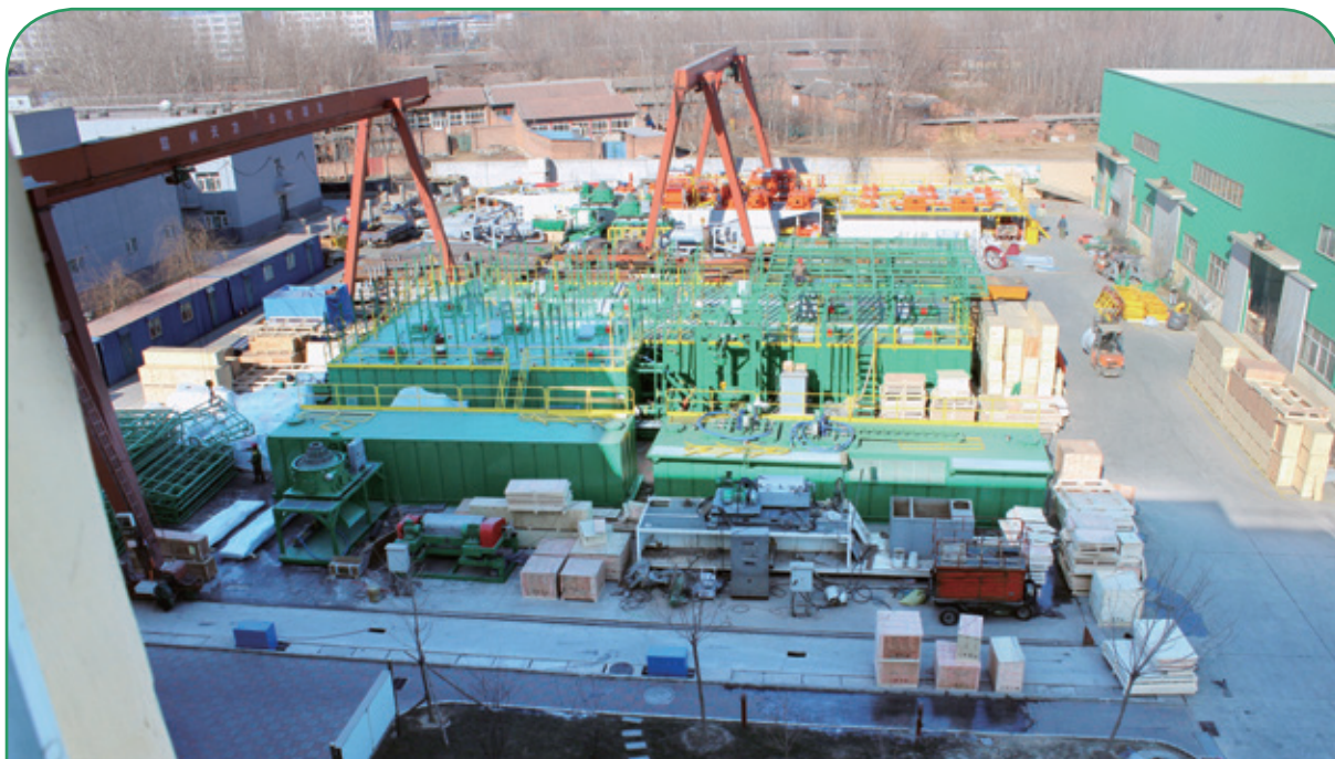
泥浆净化系统组装场
